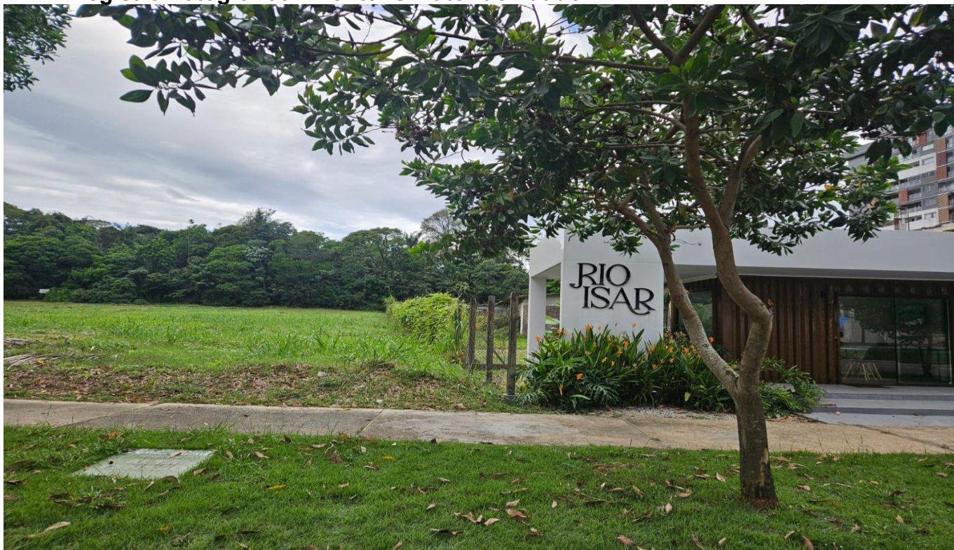
Foto 01- confinante com o Residencial Rio Isar.
