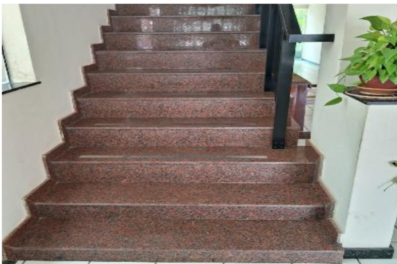
Foto 17 - Escada de Acesso do primeiro andar para o segundo andar
