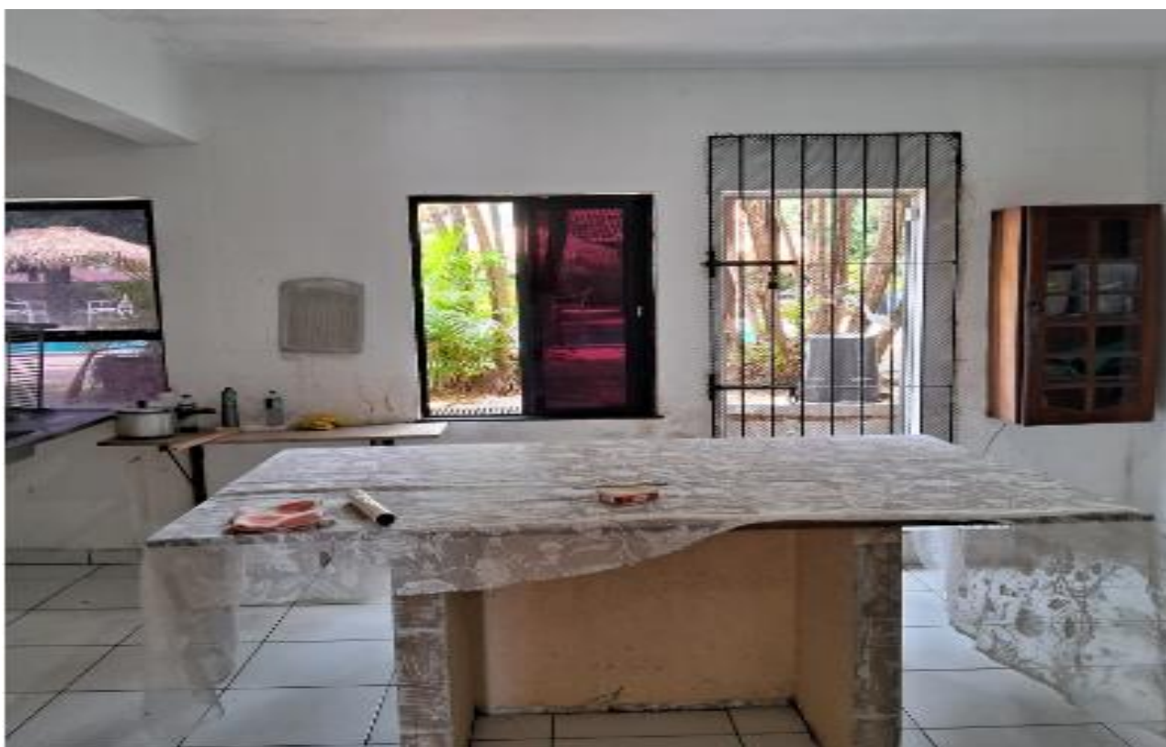
Foto 26 – Área interna da cozinha
