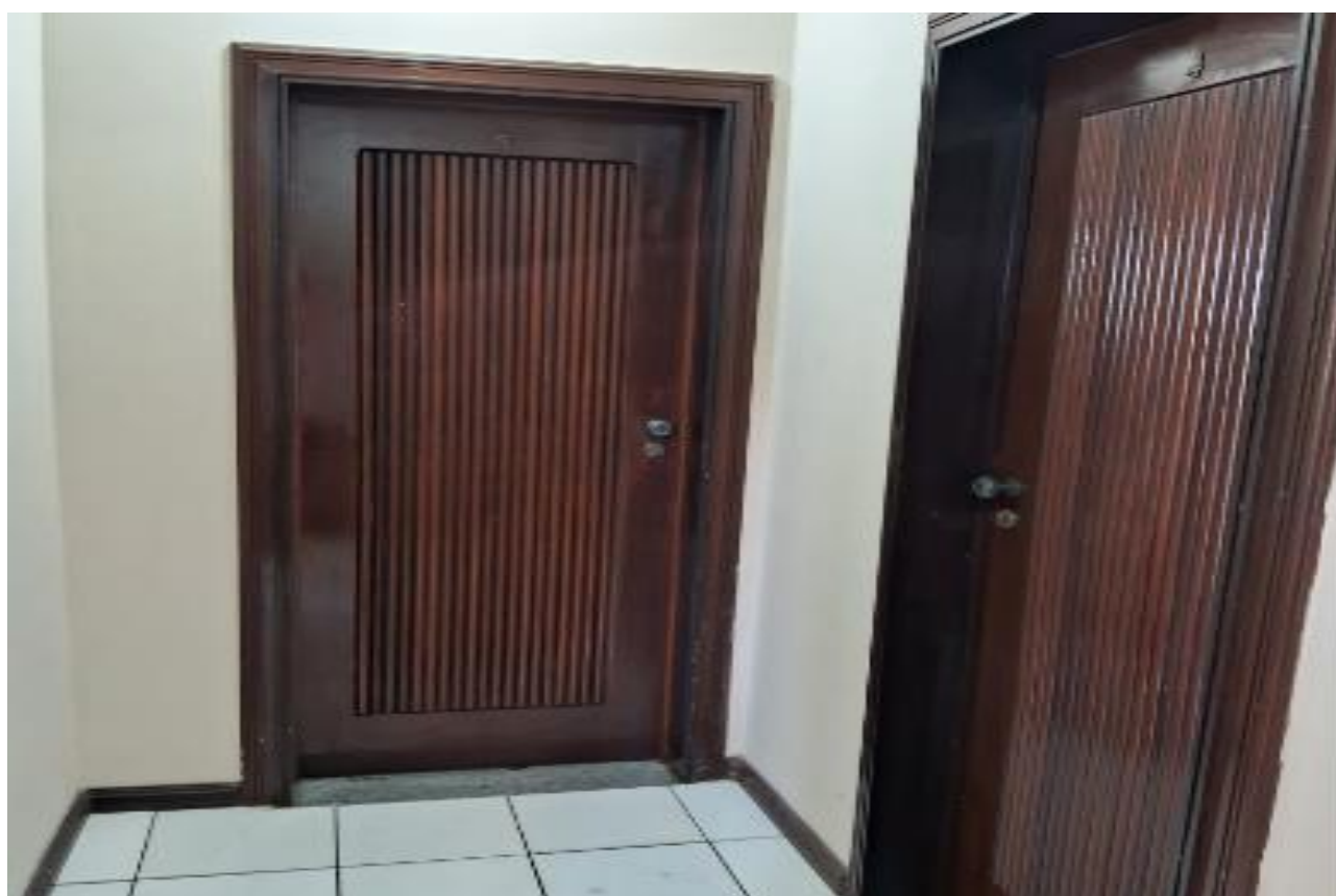
Foto 11 – de entrada para apartamentos no piso superior
