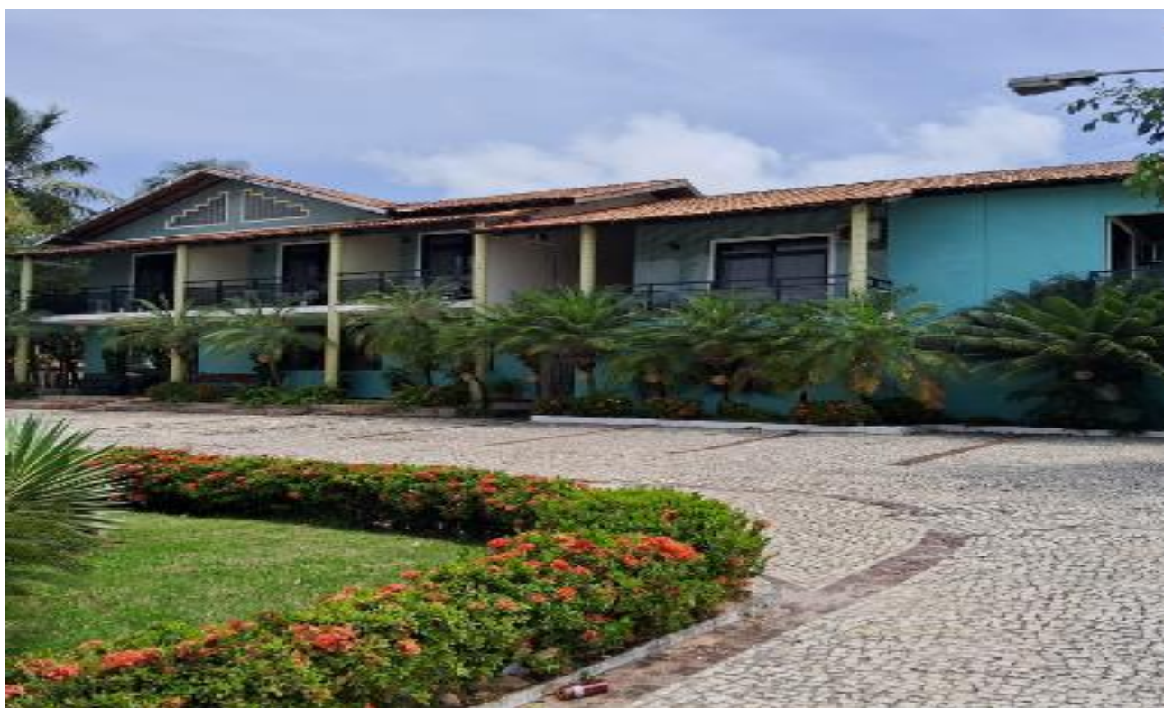
Foto 2 – acesso pelos 2 lados do imóvel
