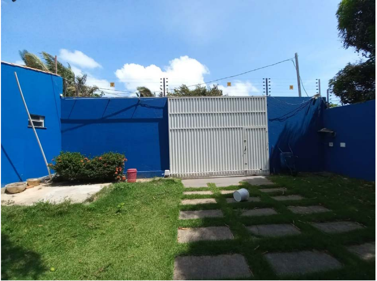
Foto 2 - Vista interna do portão
