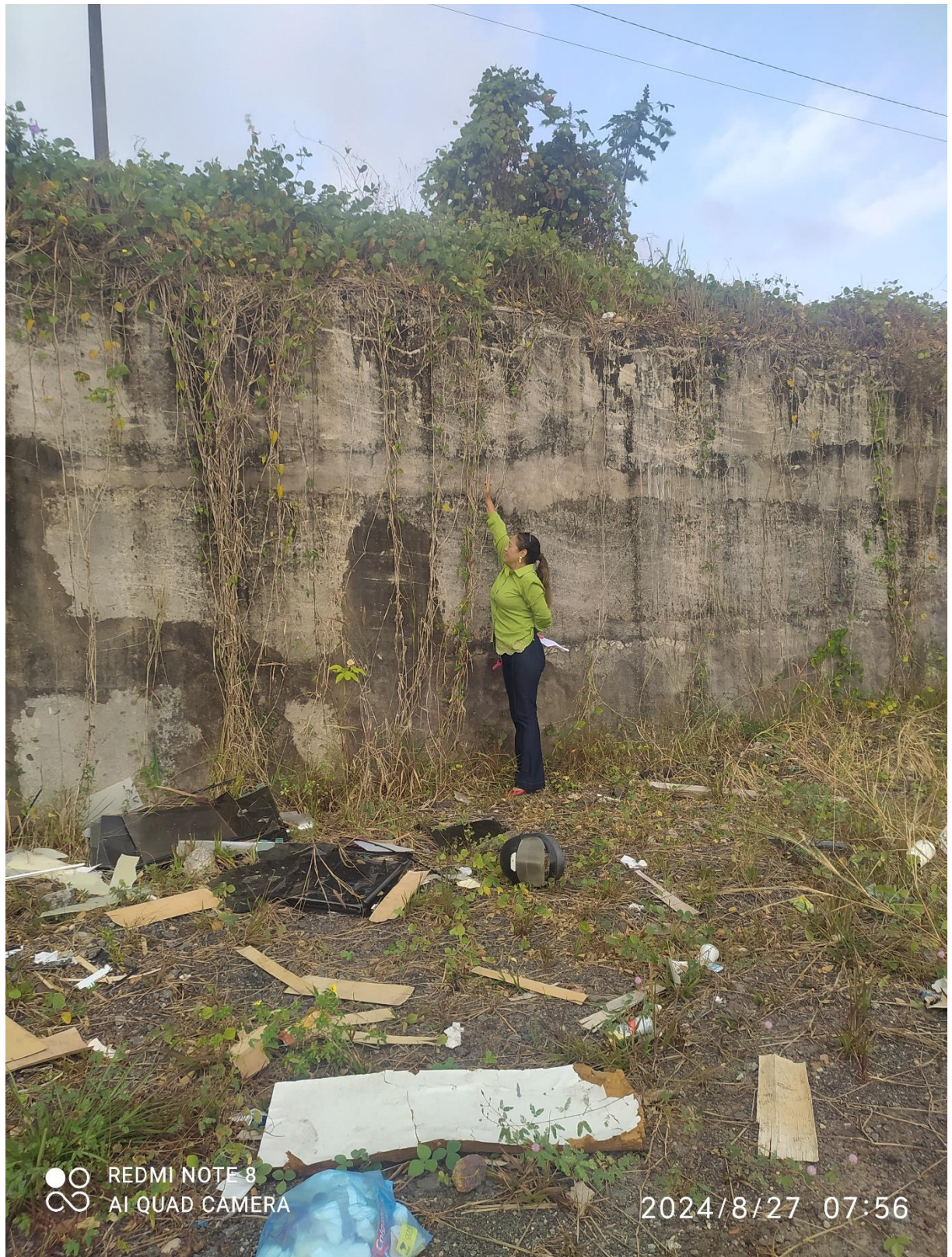
Foto 10 – Imagem interna do muro de arrimo
