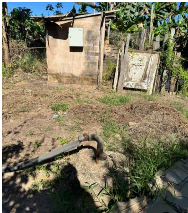
Casa de bomba d'água desativada
