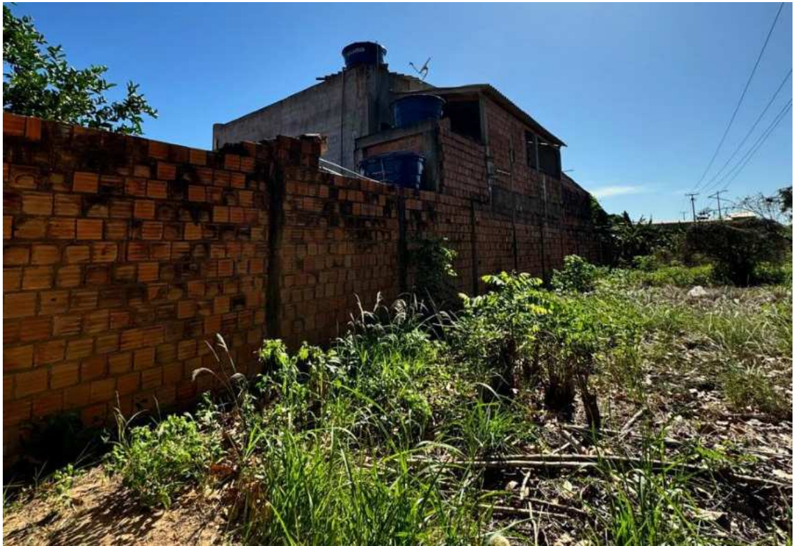
Muro servindo de arrimo para construções de terceiros
