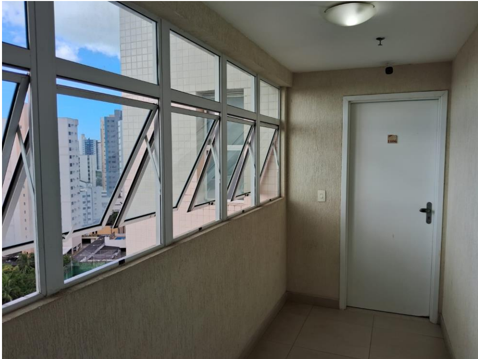
Foto 8 – Corredor de acesso ao apartamento
