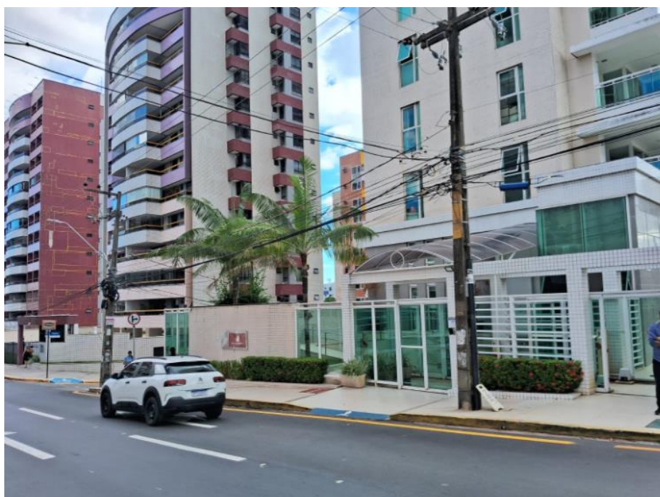
Foto 3 – Acesso ao condomínio (Rua dos Bicudos)
